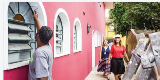
Cem escolas e CMEIs recebem melhorias antes da volta às aulas
